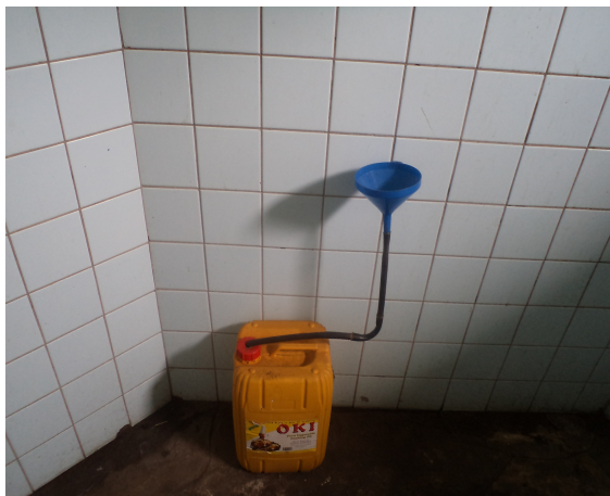
Photo 1. Dispositif de collecte, stockage et hygiénisation de l'urine
